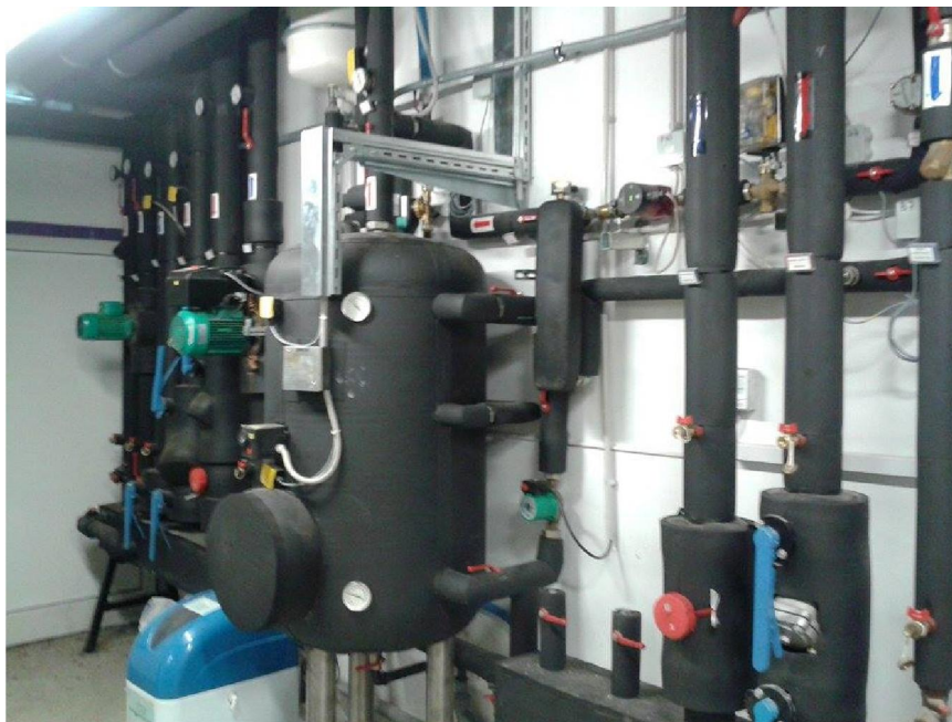
Slika 9: Črpalka za podtalno vodo (Vir: lasten)
