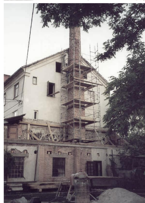
Slike 46, 47 | Obnova strehe leta 2009.
