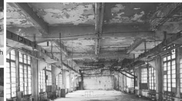
Slika 24 | Hennebiqov konstrukcijski sistem s strukturo vidnih primarnih in sekundarnih nosilcev; Pollakova tovarna usnja oz. Tovarna Rog v Ljubljani.
