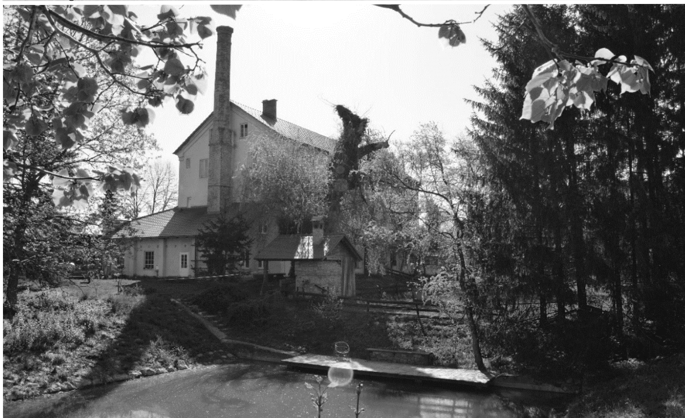
Slika 58 | Pogled s cestne strani.
