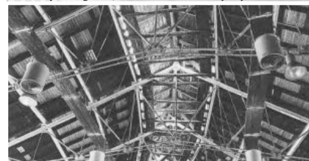
Slika 21 | Primer jeklene palične strešne konstrukcije iz osemdesetih let 19. stoletja; Železniške delavnice v Ljubljani.
