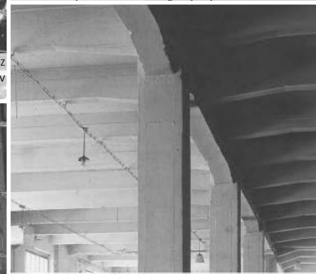
Slika 25 | Armiranobetonska konstrukcija iz časa po prvi svetovni vojni; Tovarna Droga v Izoli.
