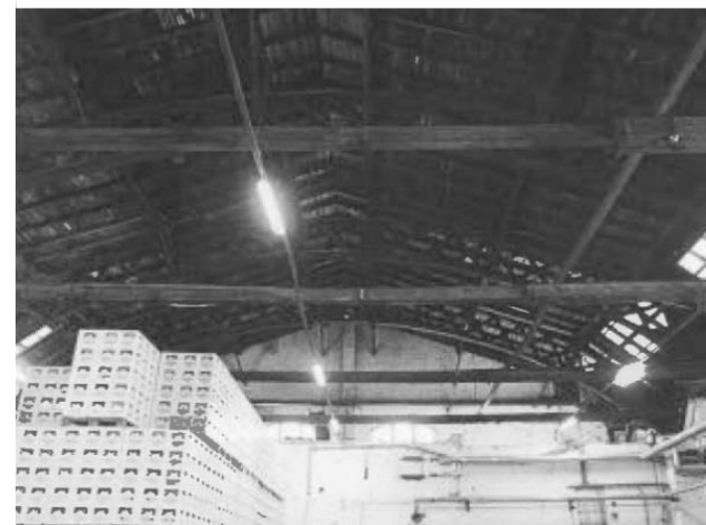
Slika 20 | Lesene stropne in strešne konstrukcije zgodnjih industrijskih zgradb; Pivovarna Union v Ljubljani.
