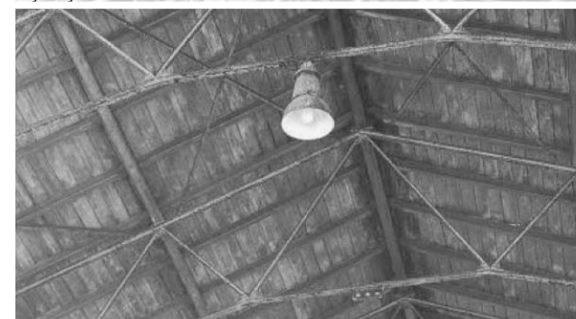
Slika 22 | Jeklena palična strešna konstrukcija iz tridesetih leti 20. stoletja; Mestna klavnica v Ljubljani.
