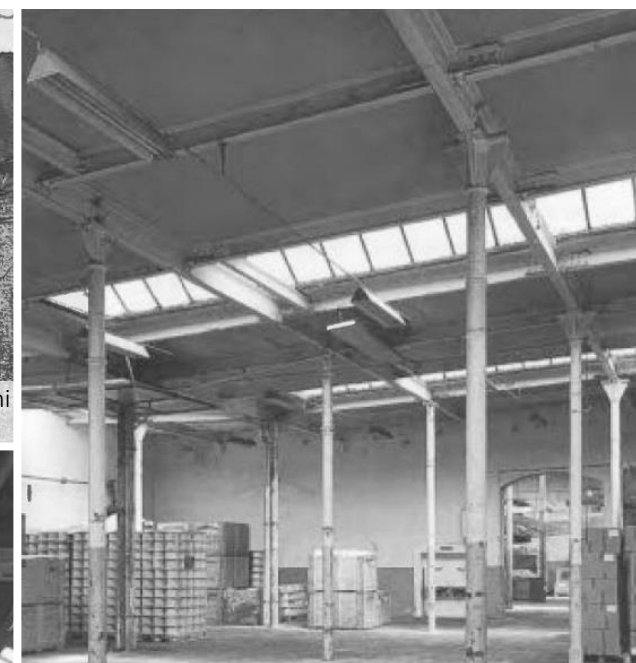
Slika 23 | Litoželezni stebri so zamenjali notranje predelne stene večjih tovarniških hal na Slovenskem v zadnji tretjini 19. stoletja; Bombažna predilnica in tkalnica v Trzinu.
