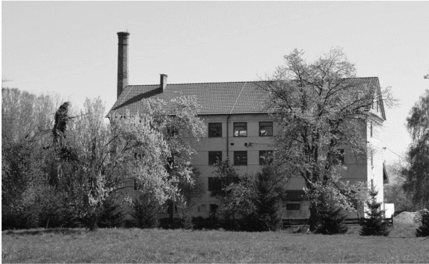
Slika 56 | Pogled s cestne strani.
