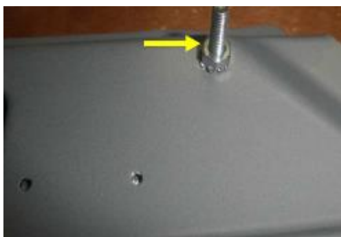
Slika 5.6: Vijačenje matice na vijak ozemljitveni.
