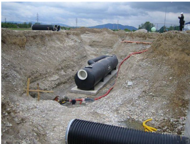
Slika 6.1 Vgradnja lovilca lahkih tekočin
