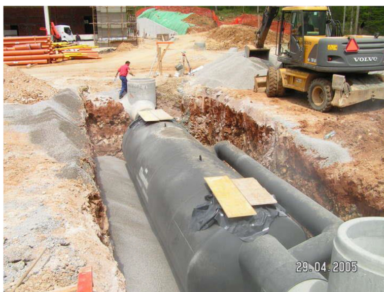
Slika 6.2 Zasipavanje lovilca lahkih tekočin z peskom
