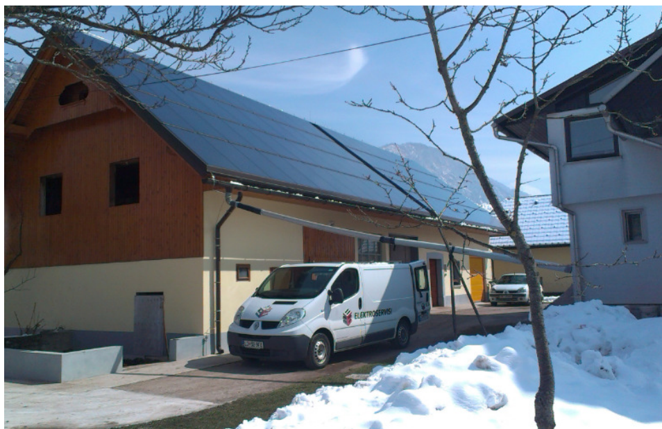
Slika 5.21: Mala sončna elektrarna Ovsenik 1 [30]
