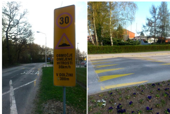
Slika 4.23: Dotrajana prometna signalizacija in označbe na vozišču
