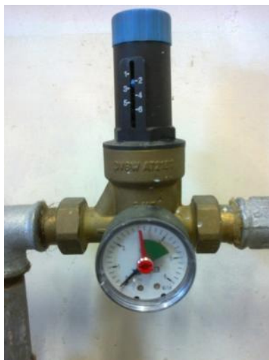
Slika 4.3. Reducirni ventil
