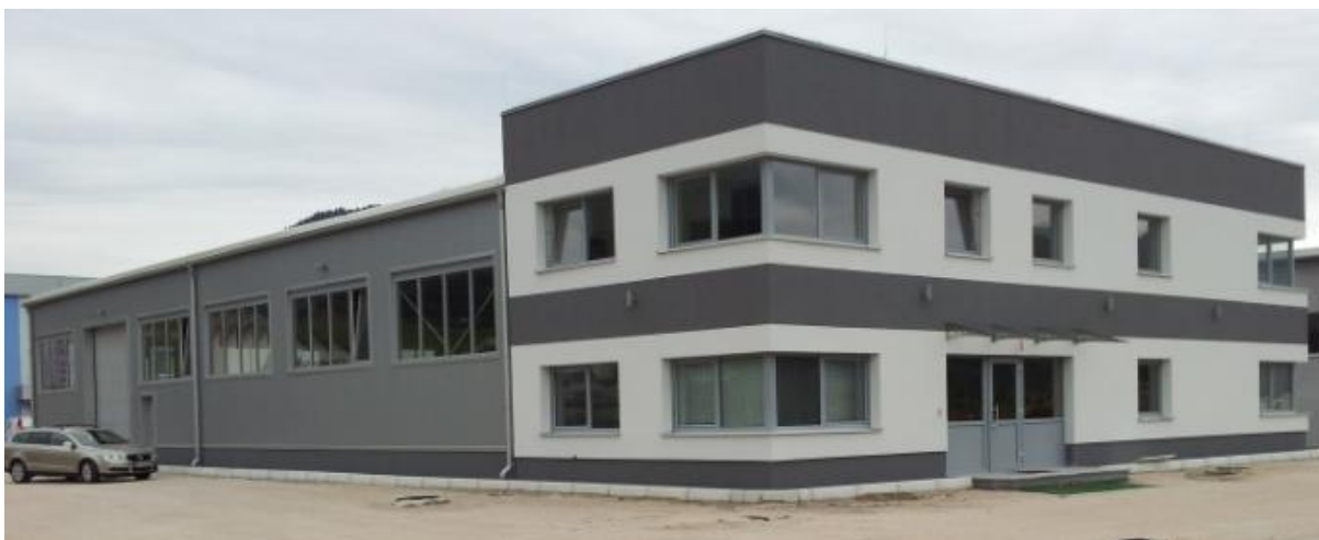
Slika 4.1: Obravnavan objekt - Proizvodna hala
