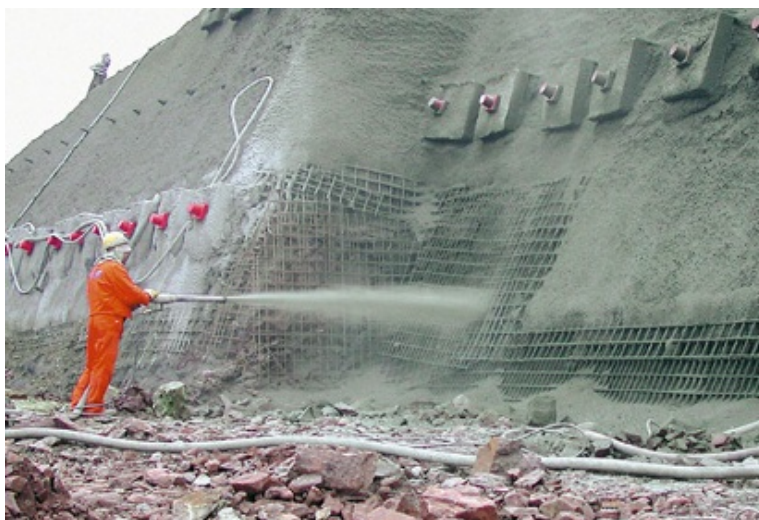
Slika 5: zavarovanje stene gradbene jame z brizganim betonom (vir: http://www.heidelbergcement.com )
