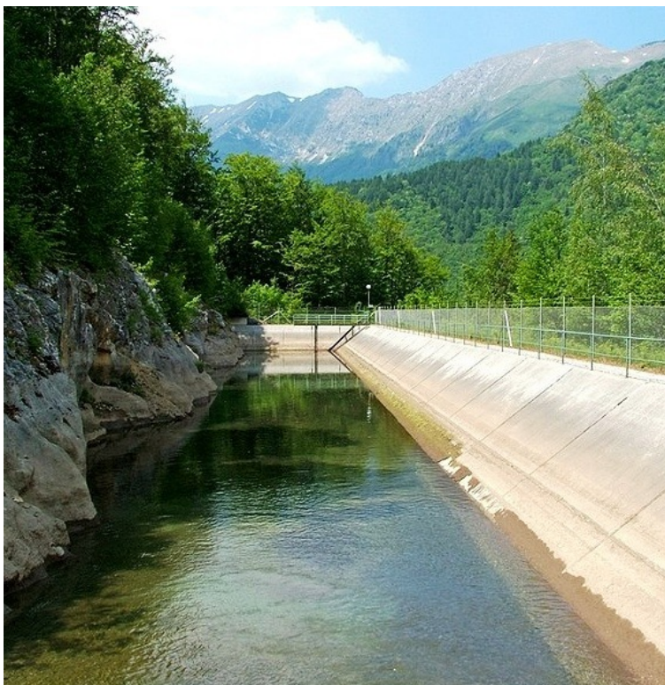
Slika 9: akumulacijski bazen MHE Bača – na levi strani slike brežina zavarovana z brizganim betonom (vir: http://www.seng.si/galerija/male_he )
