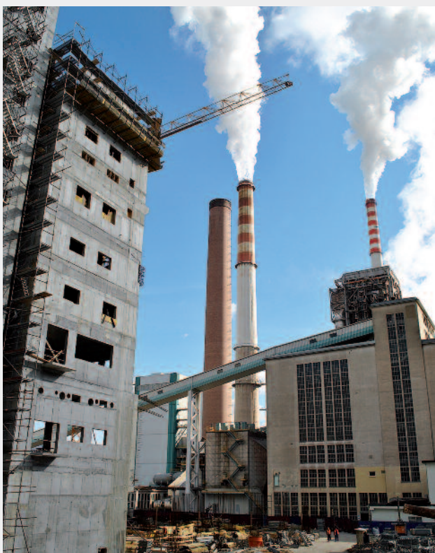
Razgibani utrinki z gradbišča TEŠ 6.
