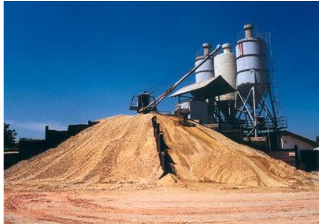
Slika 2: Betonarna podjetja Žiher d.o.o.
