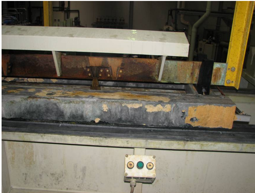
Slika 16: Poškodbe konstrukcije
