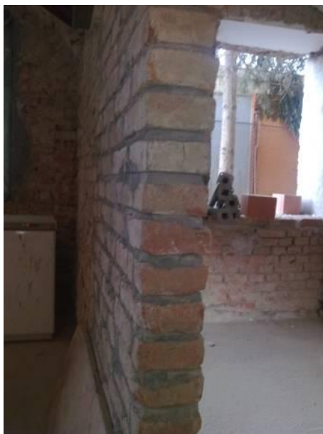
Slika 3.5: Predelna stena v pritličju
