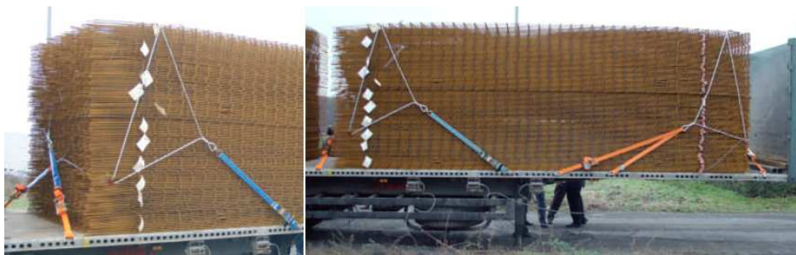
Slika 124: Pritrjevanje armaturnih mrež s posebnimi zankami in pasovi za pritrjevanje
