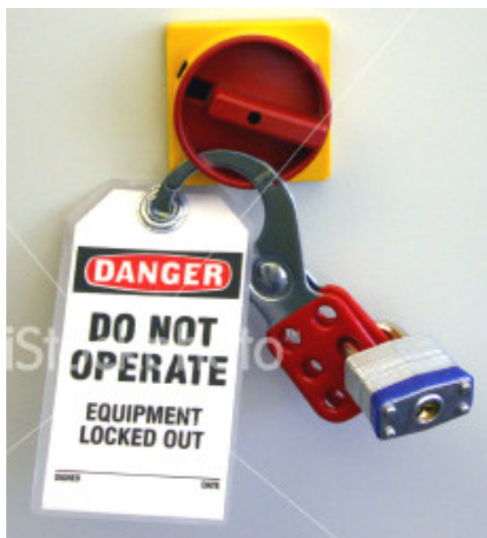
Slika 9.1: Blokirano glavno stikalo
