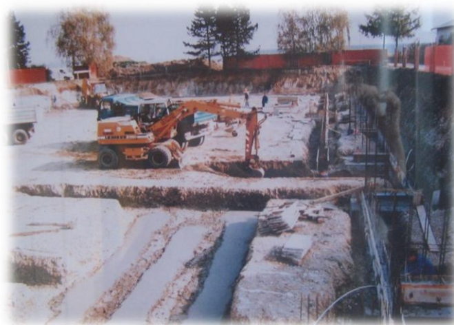
Slika 33: Začetek gradnje nove šole
