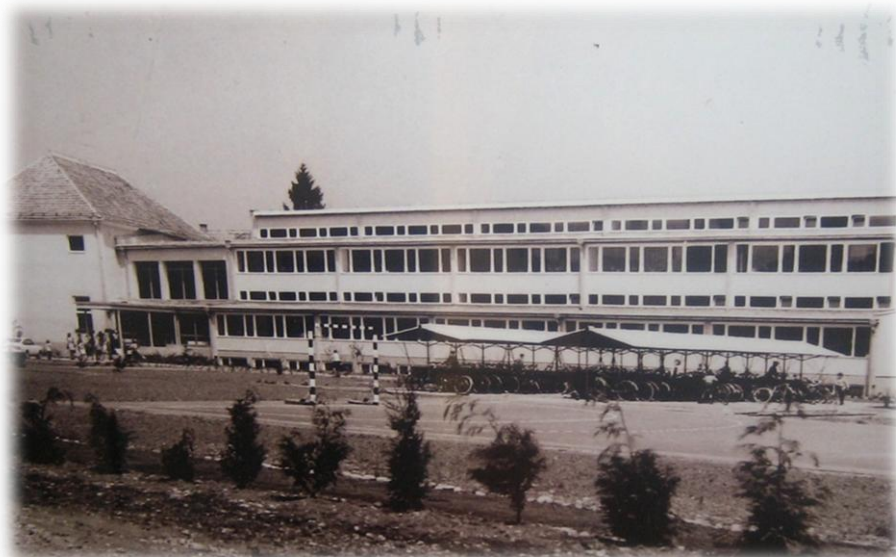
Slika 29: Nova montažna šola
