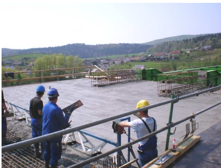
Slika 3.11: Betoniranje zgornje plošče 1. takta
