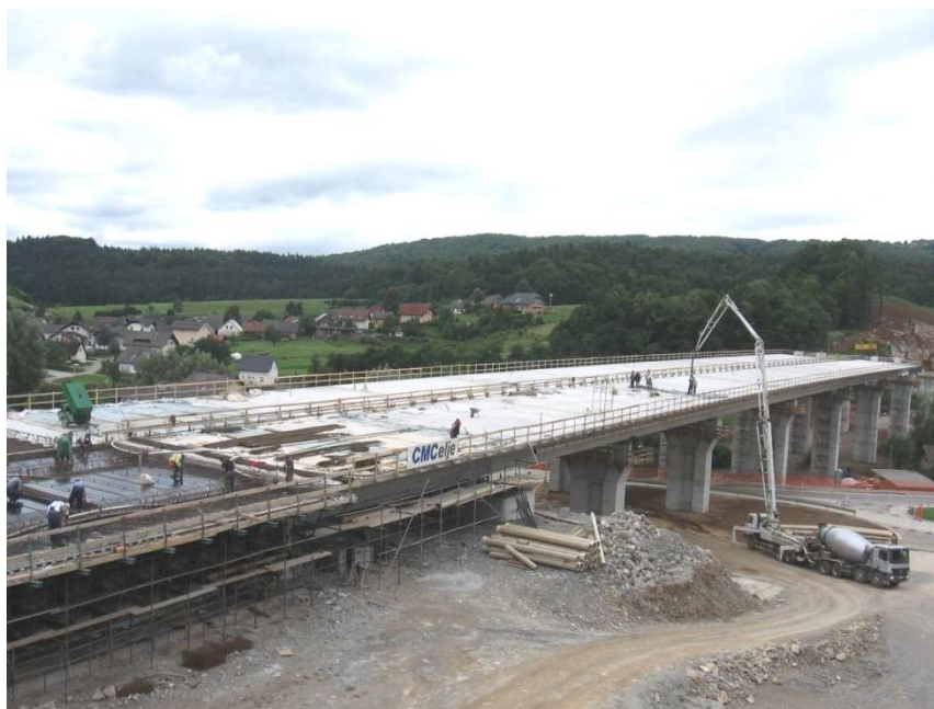
Slika 3.12: Pogled na viadukt v času gradnje
