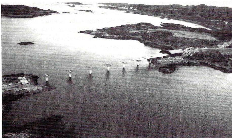
Slika 2.9: Gradnja mostu Skye
