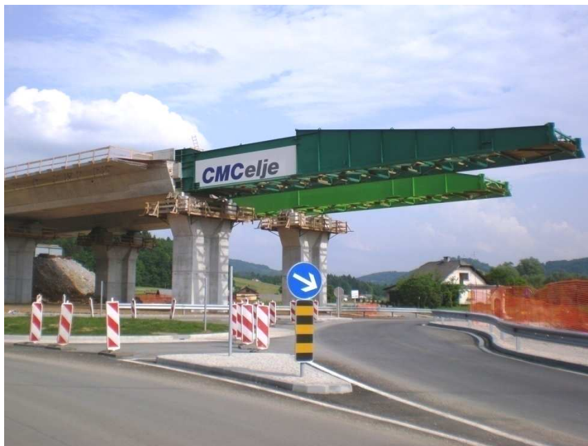
Slika 3.15: Narivanje prekladne konstrukcije prek cestišča
