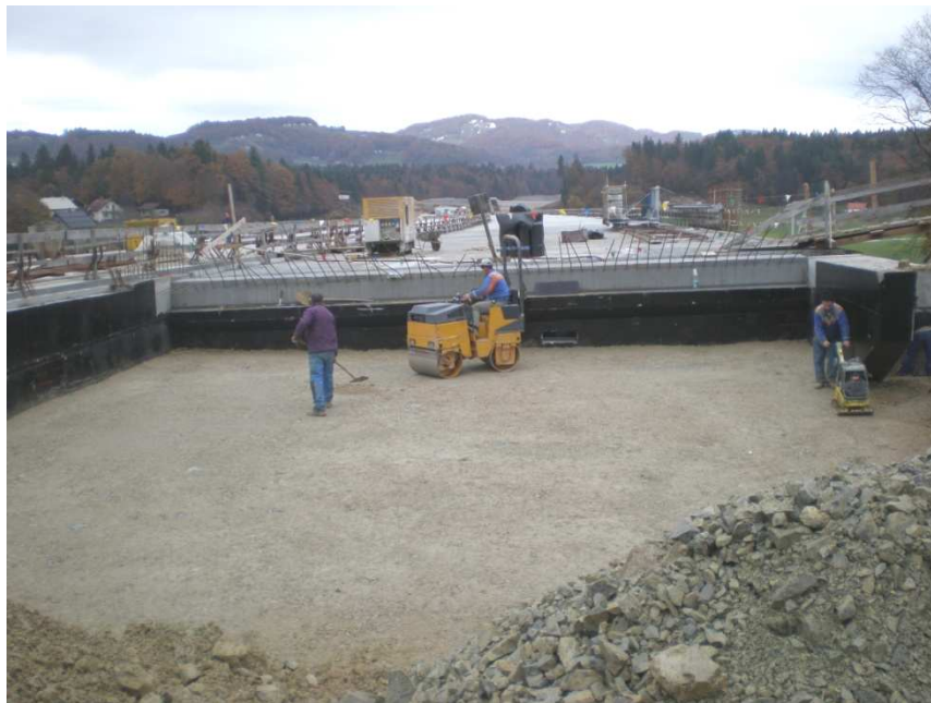
Slika 3.7: Izvedba zasipnega klina za opornikom
