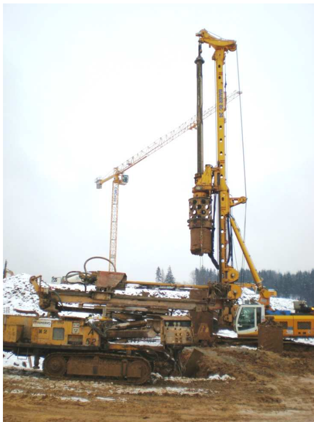
Slika 3.2: Izkop za pilote
