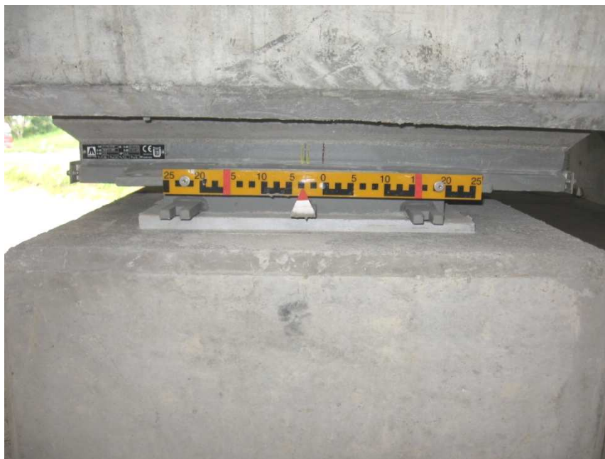
Slika 3.17: Ležišče na krajnem oporniku
