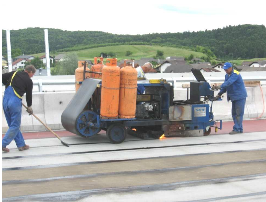
Slika 3.18: Izdelava horizontalne hidroizolacije
