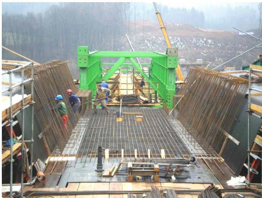
Slika 3.10: Polaganje armature spodnje plošče in stojin 1. takta
