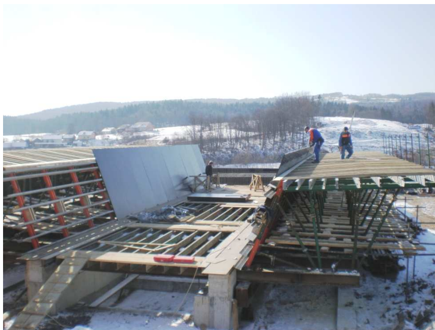
Slika 3.1: Izdelava betonskih delavnic
