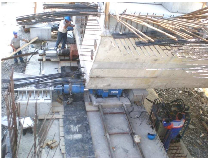
Slika 3.14: Narivanje zadnjega takta
