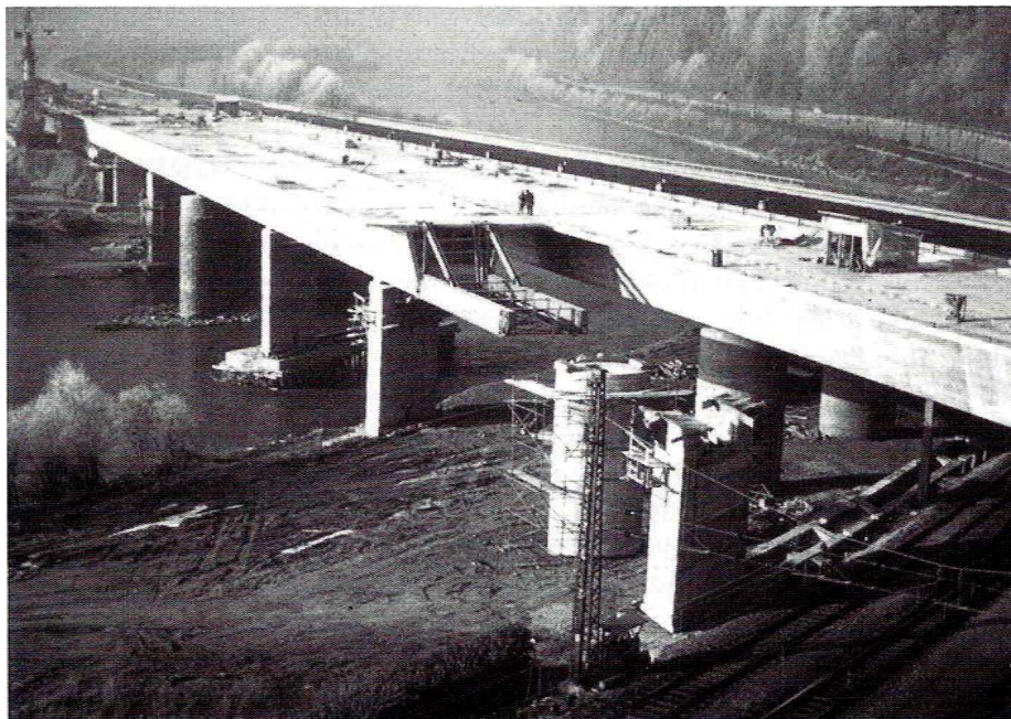
Slika 2.8: Narivanje mostu Kufstein z začasnimi kvadratnimi stebri
