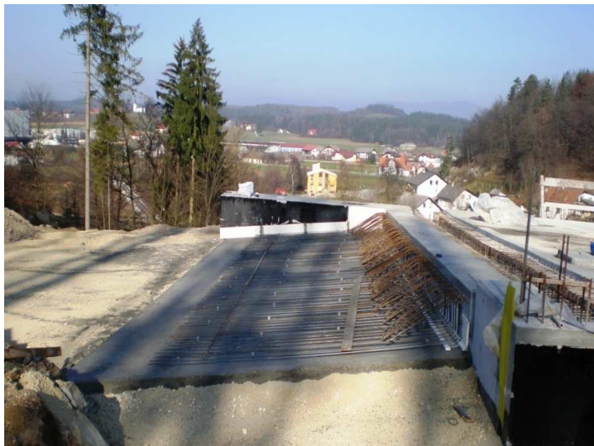
Slika 3.8: Izdelava prehodne plošče
