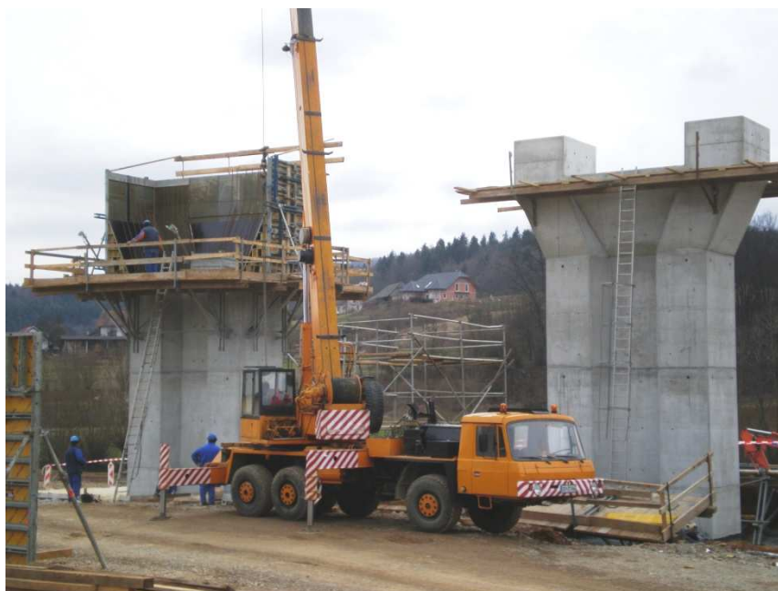
Slika 3.6: Izdelava glave stebra
