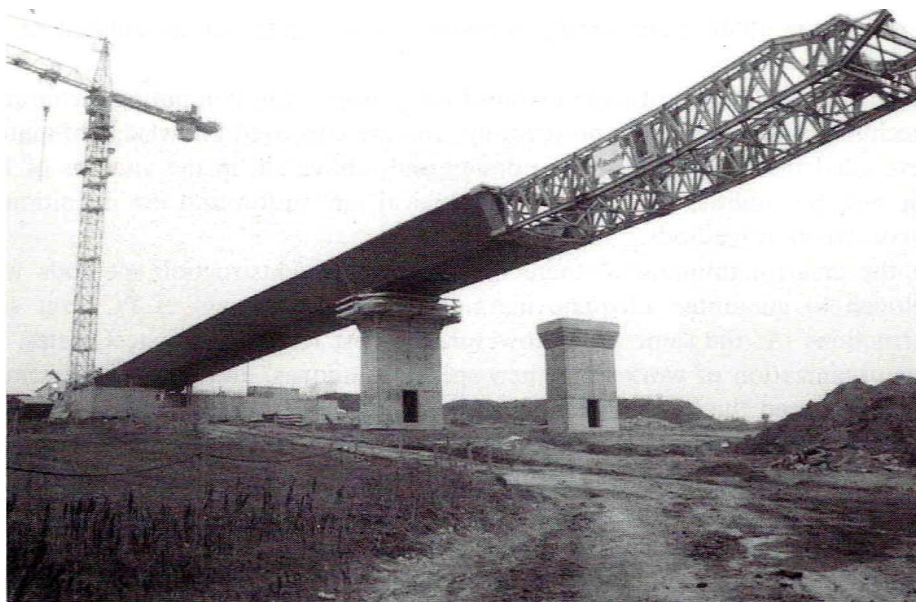
Slika 2.1: Postopno narivanje jeklenega grednega mosta
