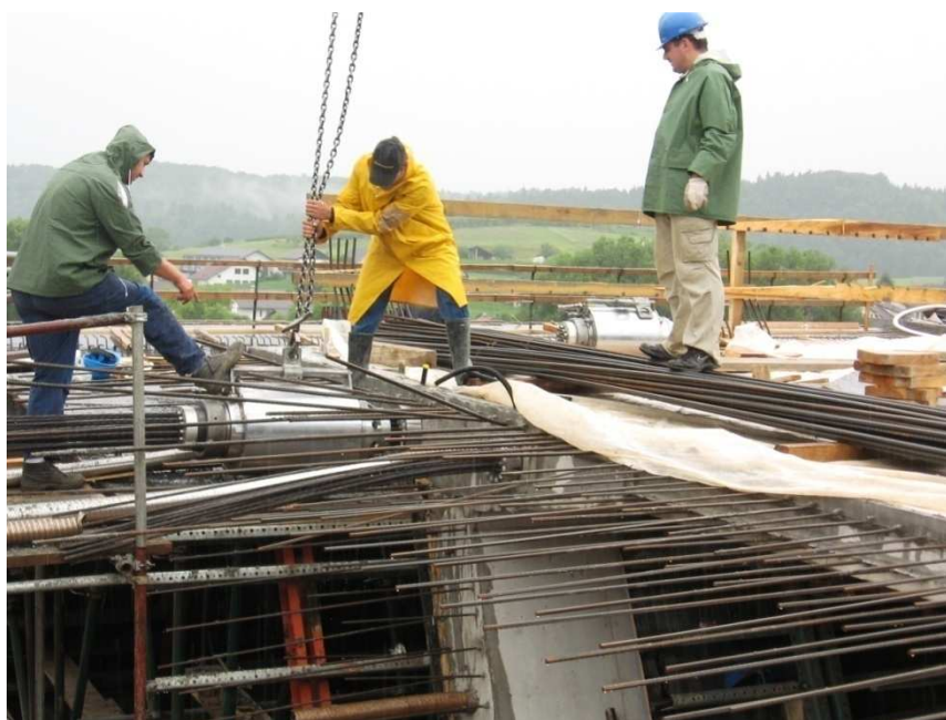
Slika 3.13: Nameščanje napenjalke
