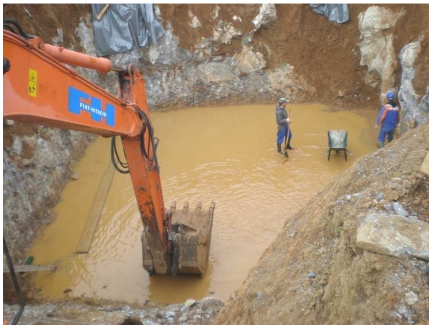
Slika 5.1: Vdor vode v gradbeno jamo
