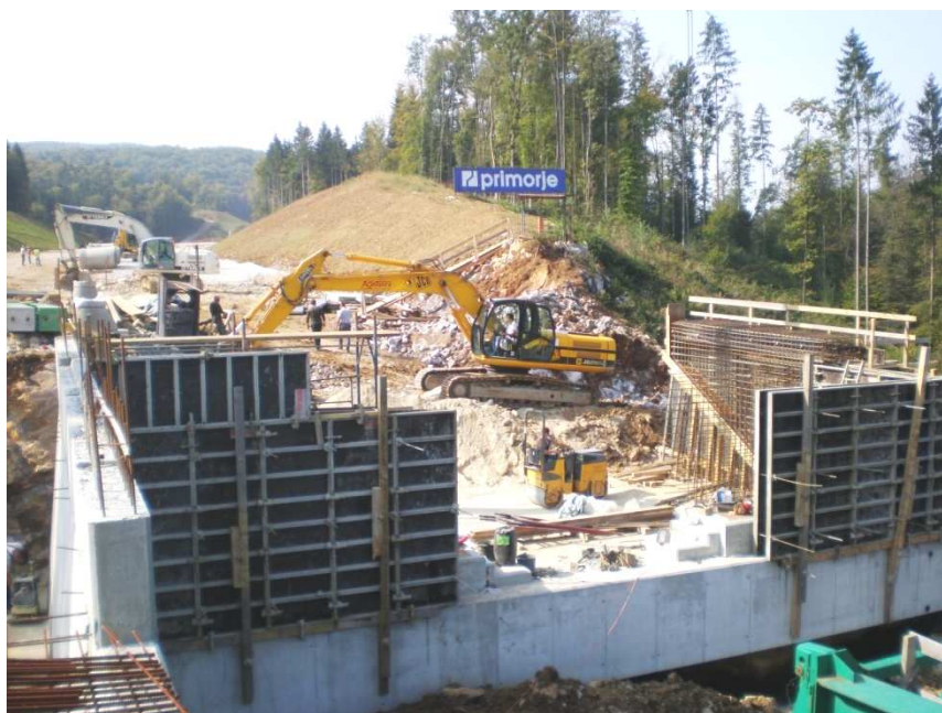
Slika 3.5: Izdelava levega opornika na ljubljanski strani
