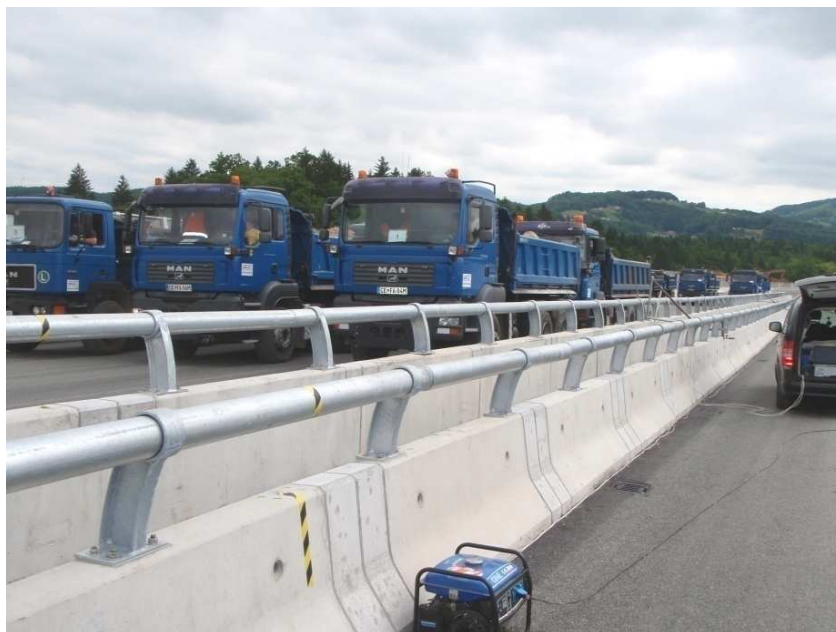
Slika 4.1: Obremenitev 6. in 8. polja levega objekta – 2. obtežni primer
