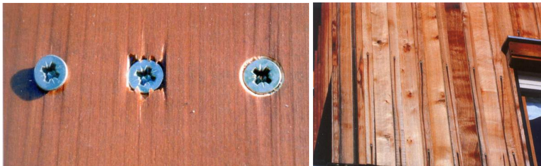
Slika 3.23.: Negativne posledice nepravilno izvedenega vidnega zunanjega pritrjevanja oblog.
