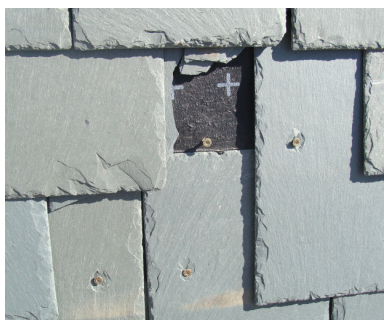
Slika 4.37.: Struktura nevidnega pritrjevanja skrilavca, ki pa ga posnema tudi pritrjevanje skodel.
