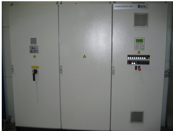
Slika 3.2: Elektro omara z glavnim stikalom
