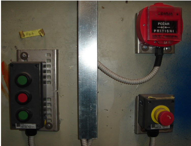
Slika 3.9: Stikala nameščena na barvni komori
