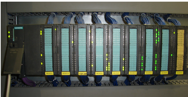
Slika 3.15: Krmilnik z vhodno-izhodnimi moduli
