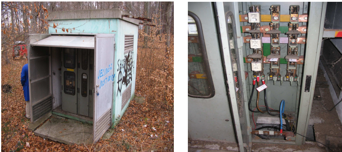
Slika 17: TP 374 – uporabljen kot pomožno ozemljilo
