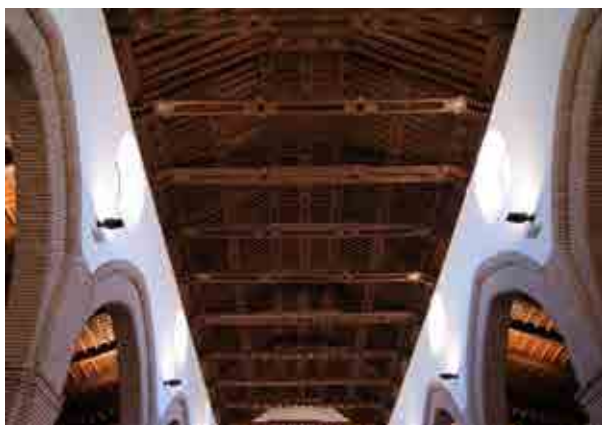
Armadura de la nave central
