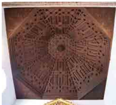
Armadura octogonal del presbiterio.
