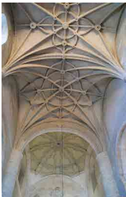
Cubiertas de la nave y el presbiterio.
