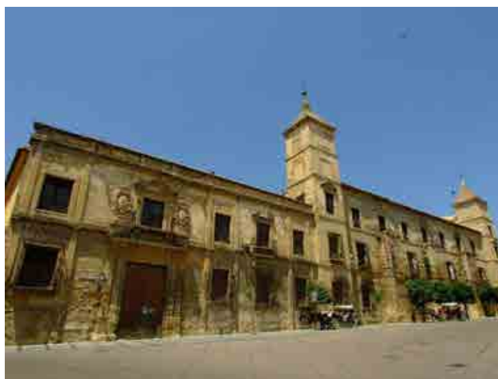
Fachada principal de la calle Torrijos
