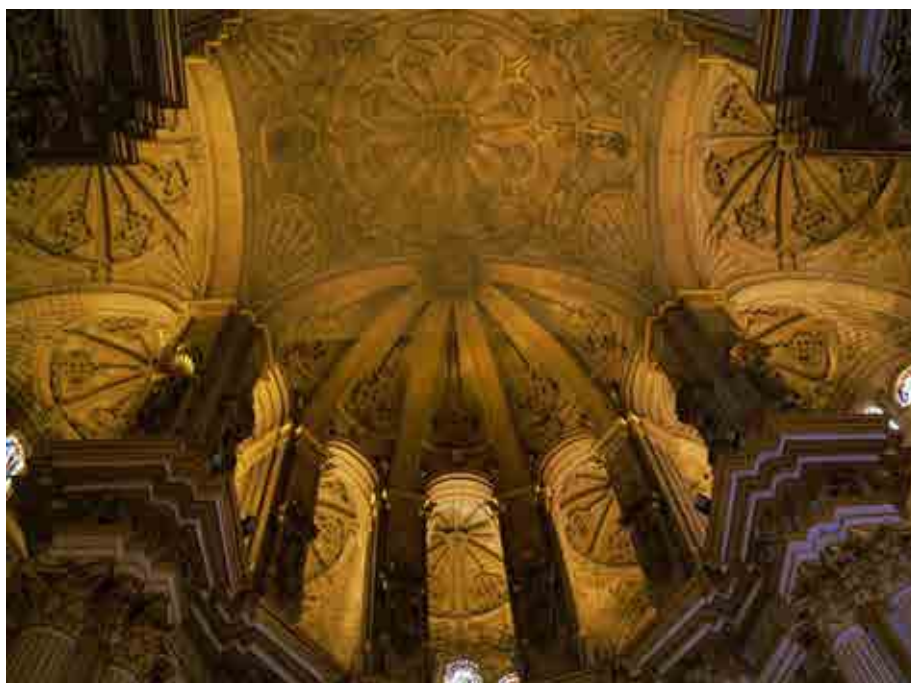
Cubiertas de la cabecera.
