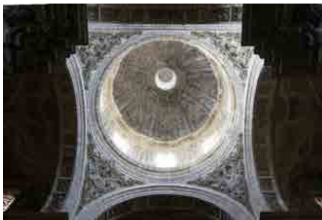
Cúpula sobre el crucero.
