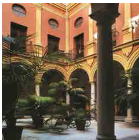
Patio del ala sureste del Palacio.
