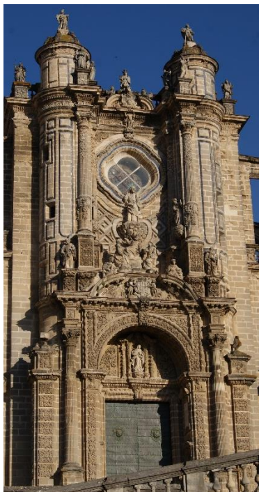
Puerta central de la fachada principal.
