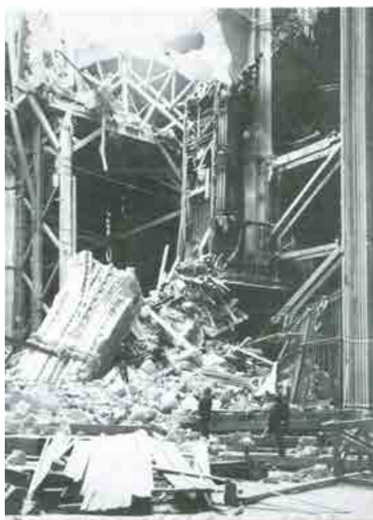
Hundimiento del cimborrio. Julio de 1888.
