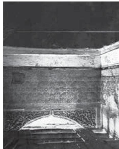
Vista de la Sala Norte durante el desmontaje del forjado existente hasta 1931 que dividía el espacio en dos plantas.
