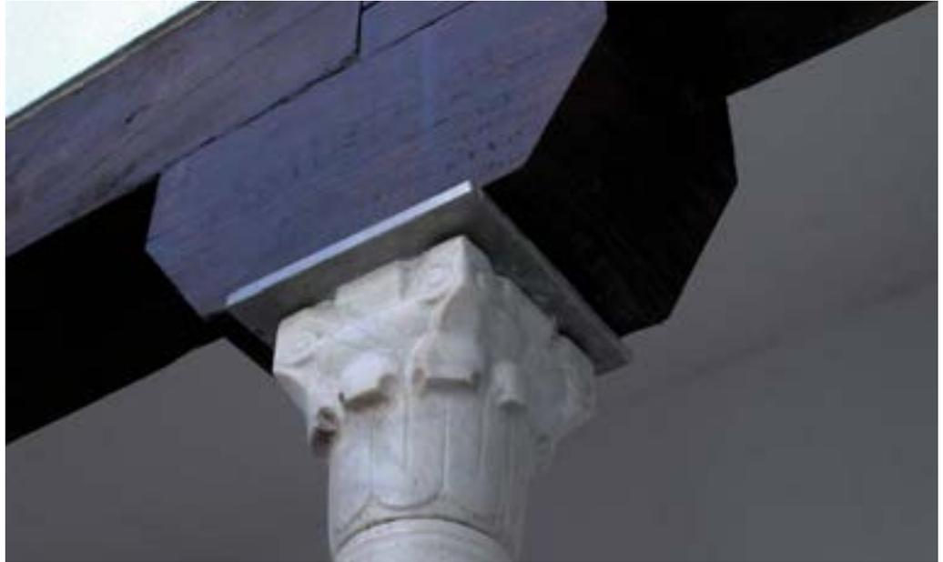
Detalle de la solución anti-sismo en las columnas del patio de la casa del Gigante. Ronda.
