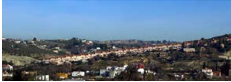
Figura 7.82: Jaén, Aproximación por la A-44, nuevas viviendas en hilera en el entorno del río Guadalquivir. Fuente: Elaboración propia .
