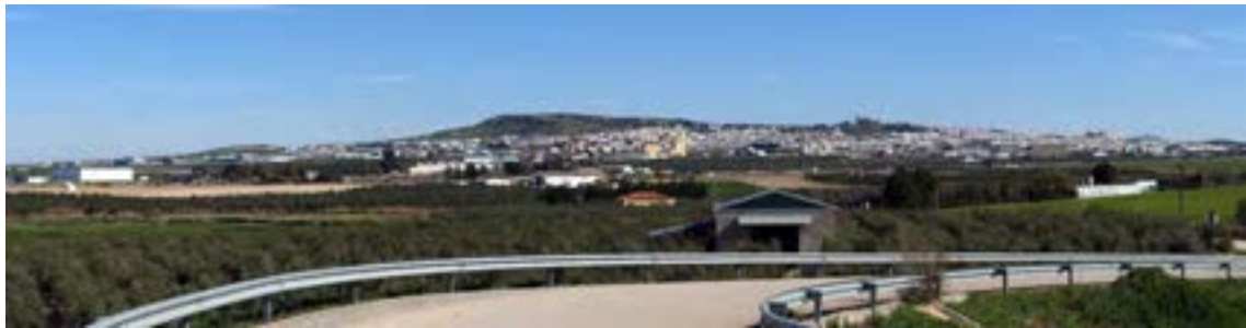
Figura 7.59: Osuna. Vista semejante a las que se obtendrán desde la línea de ferrocarril de alta velocidad, tomada desde uno de sus puentes. Fuente: Elaboración propia .
