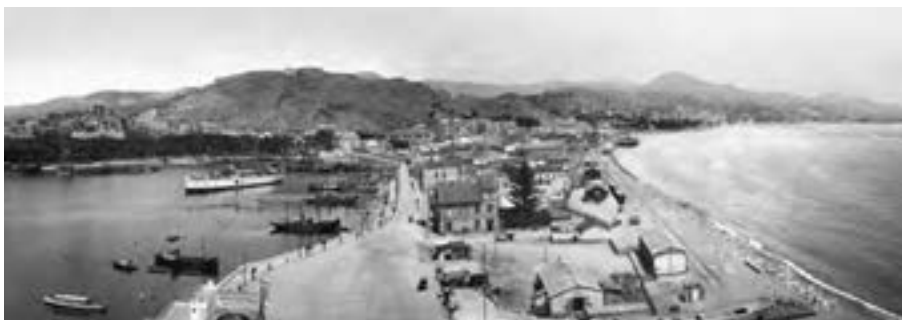
Figura 7.147: Málaga, H61: Vista desde la Farola. Roisin, ca. 1920. Fuente: Fondo Thomas y Roisin. Centro de Tecnologías de la Imagen. Universidad de Málaga. REF.: ACM-9-22434
