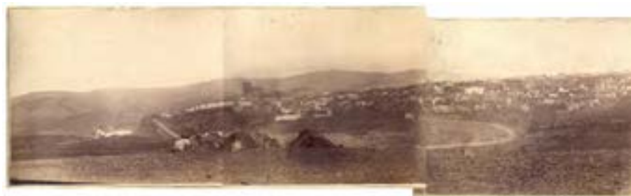
Figura 7.29: Alhama, H05. Vista de Alhama de Granada, tras el terremoto de 1884, tomada por el fotógrafo A. Esperon. Fuente: Archivo Municipal de Granada. Referencia 300438, composición propia.
