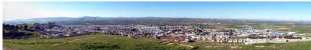
Osuna: Vista desde las Cantinas.
