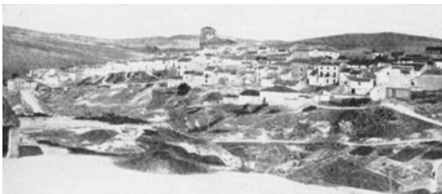
Figura 7.30: Alhama, H06. Vista desde el suroeste, a finales del siglo XIX, antes de la construcción del nuevo barrio de la Joya (1887). Puesto que no se observan daños en las edificaciones, puede inferirse que la imagen es anterior al terremoto, lo que vendría a apoyar la hipótesis de que la mirada a la ciudad desde el flanco occidental adquiere interés antes del terremoto y la consiguiente reparación. Fuente: Raya Retamero (2007, p. 98)
