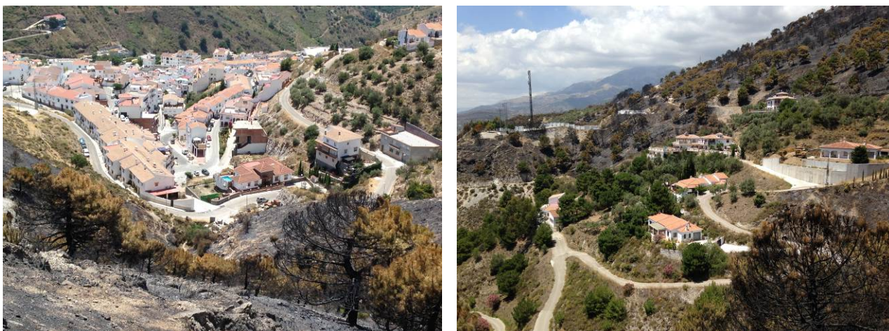
Figura 8. Zona de afección del incendio forestal en la zona de contacto con el principal núcleo, Cómpeeta (izquierda), y su zona de interfase urbano-forestal. Fuente: autor.
