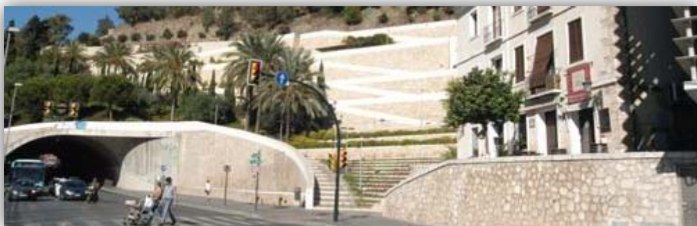
Figura 7 Entrada Este del túnel y alrededores
