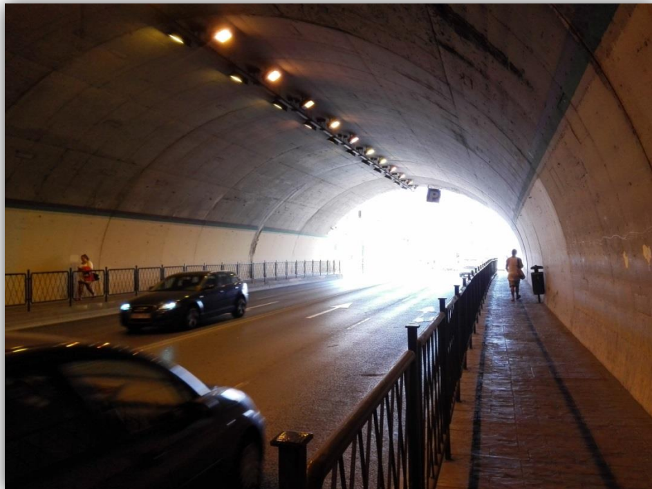
Figura 8 Vista interior del túnel
