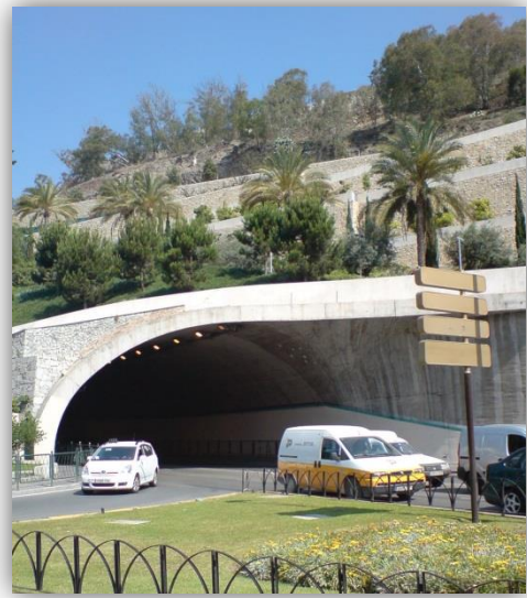
Figura 5 Entrada Este del túnel
