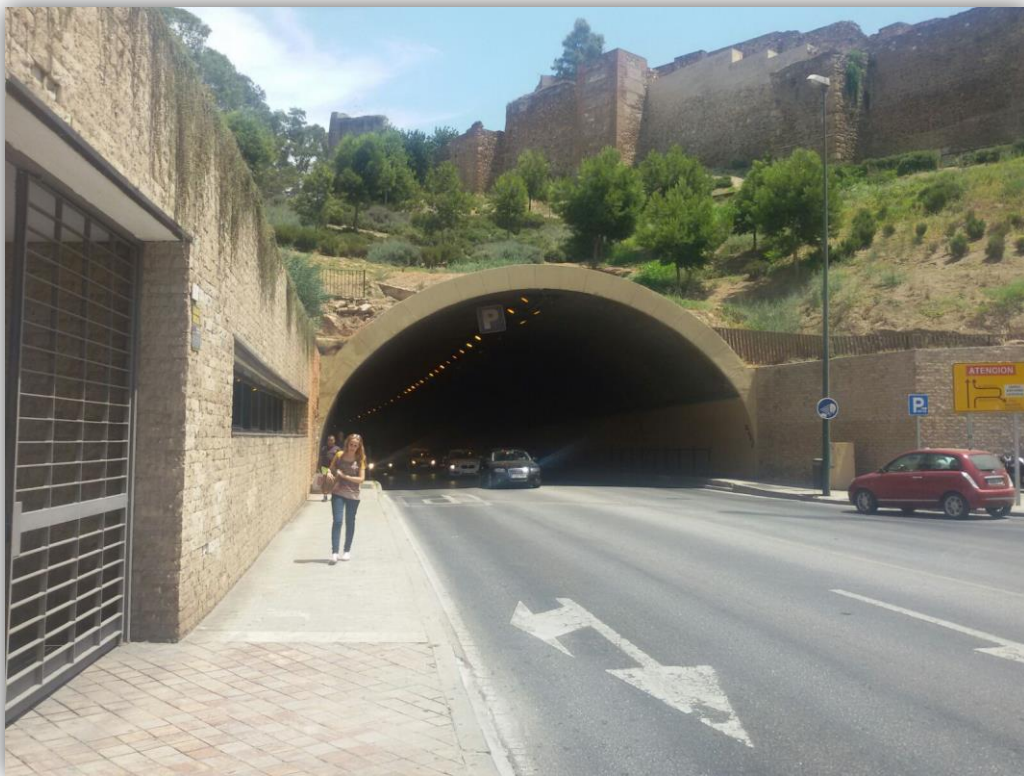
Figura 124 Entrada Oeste del túnel
