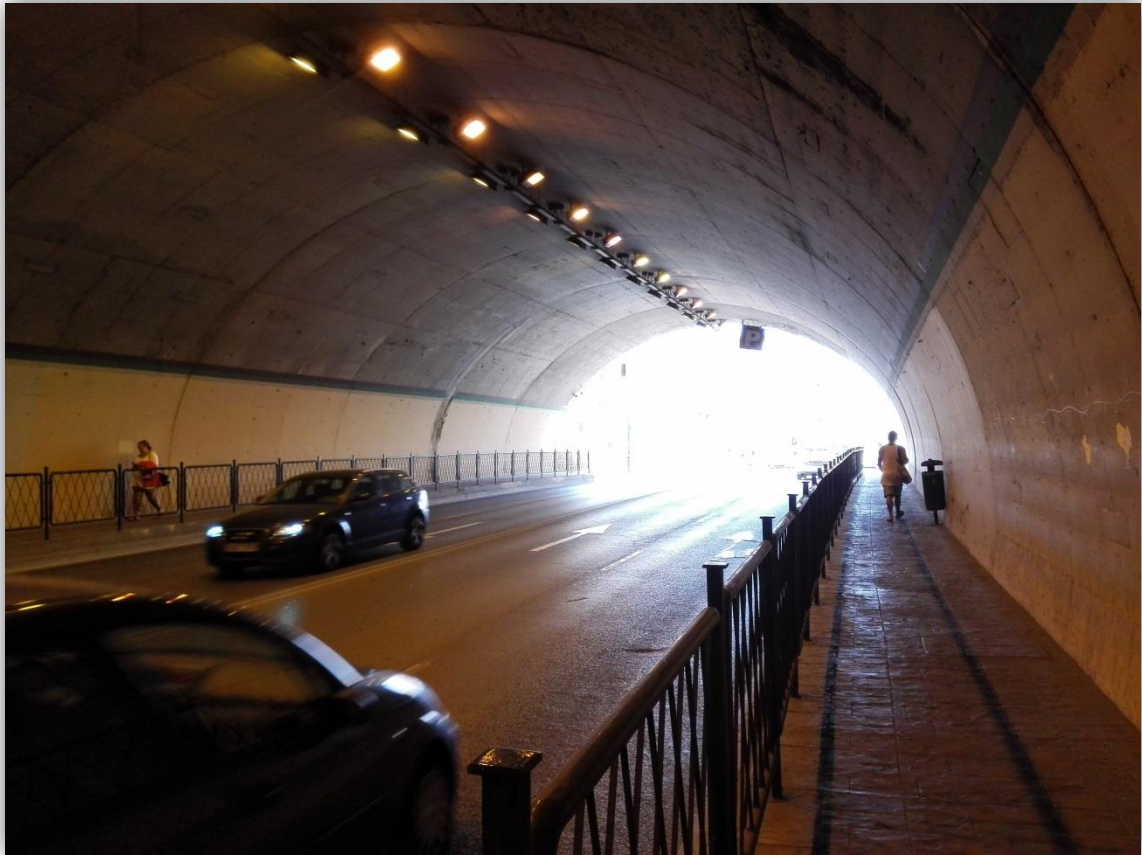
Figura 121 Vista del interior del túnel
