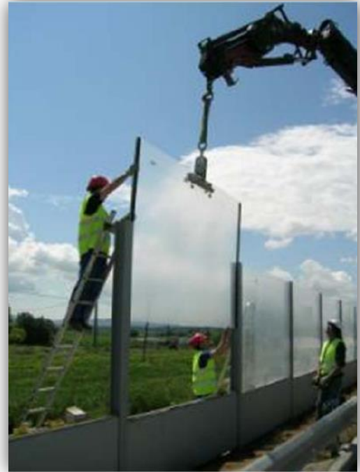
Figura 17 Puesta en obra de las barreras
