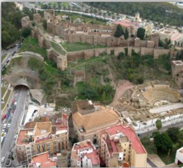
Figura 6 Vista aérea del túnel
