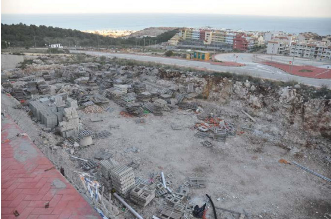
Figura 3. Imagen parcial de Santángelo Norte, una urbanización abandonada tras su finalización, con la práctica totalidad de sus viviendas sin ocupar, en las laderas de la Sierra de Mijas (Benalmádena). En estos espacios se suma la peligrosidad por los numerosos elementos de obra, residuos abandonados y suelos descompactados, que se incorporan a los flujos de inundación ya sea como áridos o como objetos de gran volumen. Foto: autor.
