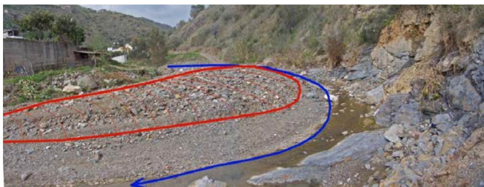
Figura 11. Arroyo Jaboneros (noviembre de 2006): Muestra de alteraciones geomorfológicas e hidráulicas tras al evento: creación de depósitos sedimentarios que modifican el eje principal del flujo con aguas bajas. Fuente: Francisco Cantarero Prados.
