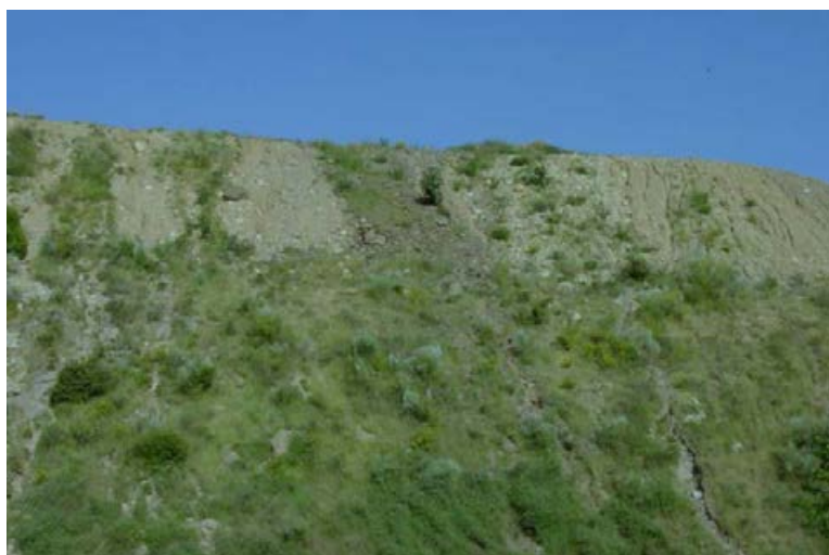
Figura 28. Depósitos de materiales sobrantes de obras para la urbanización de Parque Victoria, en las cuencas Piletas y Pollo Zamora. Fuente: Asistencias Técnicas Clave.
