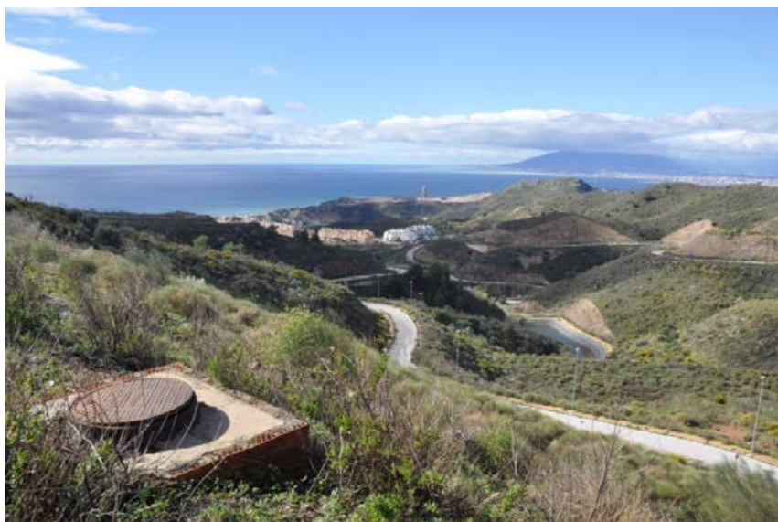
Figura 7. Urbanización Parque Victoria, con parcelas de terreno urbanizadas, pre-urbanizadas y naturales, generando numerosos espacios de fricción y con alta variabilidad temporal. Foto: autor.
