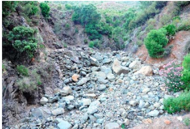
Figura 21. Aludes de piedras en el cauce del río de la Cala, en la parte alta de la cuenca. Foto: autor.
