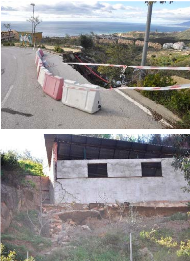
Figura 5. Detalles de movimientos en masa afectando usos periurbanos en las cuencas del arroyo Piletas (superior) y de los Jaboneros (inferior). Fotos: autor.
