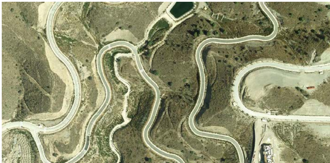
Figura 27. Estructura viaria interna en las cuencas de los arroyos Piletas y Pollo Zamora. Fuente: Google Earth.
