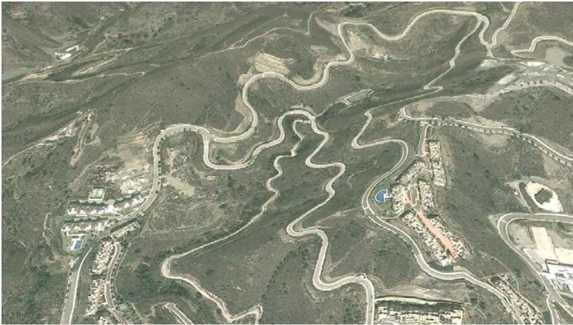
Figura 11. Detalle de viales y desmontes en las cuencas altas de los arroyos Piletas y Pollo Zamora (imagen de 2007). El desarrollo del suelo urbano se ha visto paralizado una vez construidas las infraestructuras viales y de distintos tipos recogidas en los planes parciales. Fuente: Google Earth.
