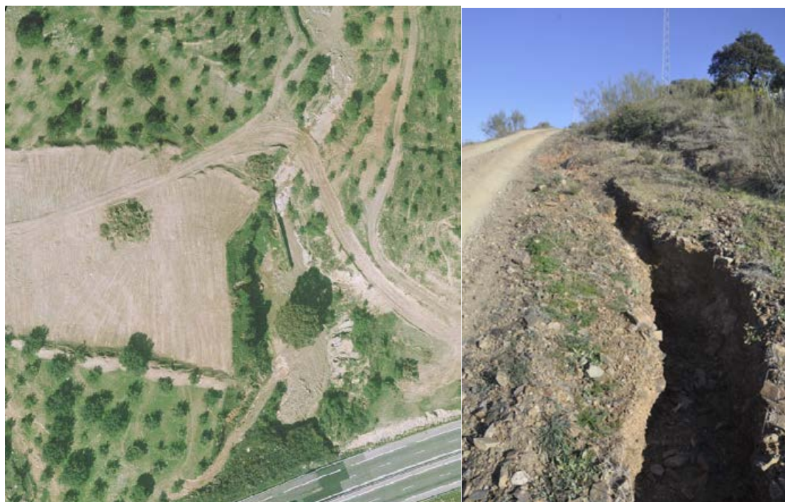
Figura 18. Imagen izda.: fotografía área del cauce del arroyo Piletas antes de embocar bajo la autovía. Se pueden apreciar los importantes depósitos de acumulación de sedimentos y la gran explanada artificial de movilización de suelo en la proximidad del estrechamiento. Imagen dcha.: erosión hídrica lineal sobre filitas, en la cuenca del arroyo Jaboneros. Fotos: Google Earth (dcha.), autor (izda.).
