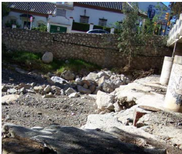
Figura 10. Arroyo Jaboneros (noviembre de 2006): Excavación en pilares. Fuente: Francisco Cantarero Prados.
