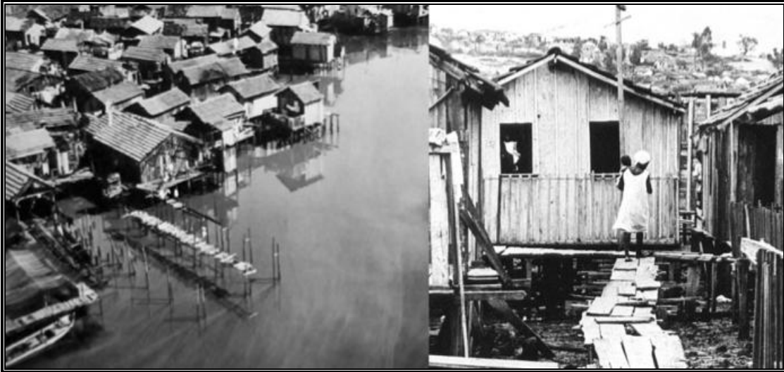
Figura 6: Palafitos en la orilla de la Baía de Guanabara
