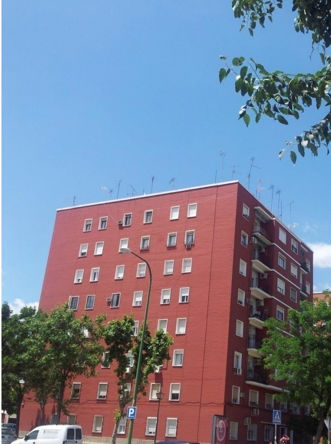
Figura 48. Vista de un edificio en calle Tarfia en Sevilla en el que se aprecia el bosque de antenas de televisión existente. Fuente: propia.
