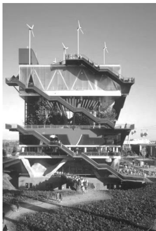
Fig 6: pabellón holandés en la Exposición Universal de Hannover 2000, MVRDV. Ejemplo paradigmático del tipo de arquitectura al que hace referencia Post Rotterdam.
