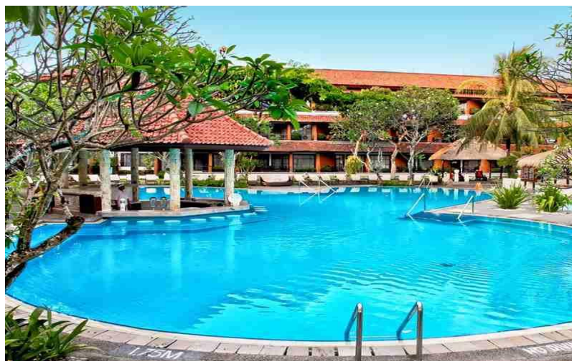
Imagen 1. Hotel “Bali Sol”. Primer hotel internacional de Meliá. En Bali (Indonesia).
