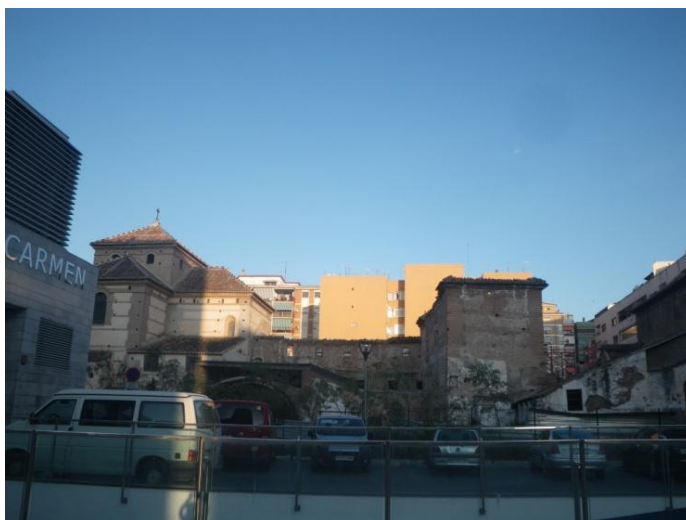
Ilustración 15 Estado actual del Convento del Carmen
