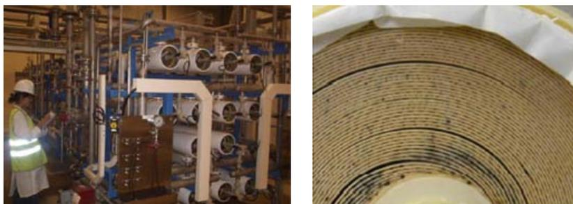
Figura 4.21. Fotografías de módulos de membrana de ósmosis inversa con configuración en espiral: (a) Disposición en planta; (b) Fallos debidos a ensuciamiento y a la formación de canales por acumulación de partículas.
