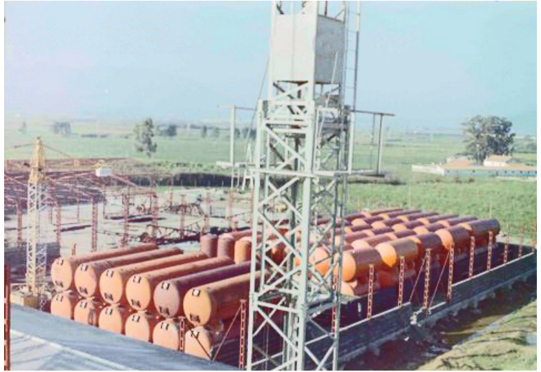
Imagen 4. Bodega de fermentación y guarda en proceso de construcción, 1869 (Colección Pedro Portillo)
