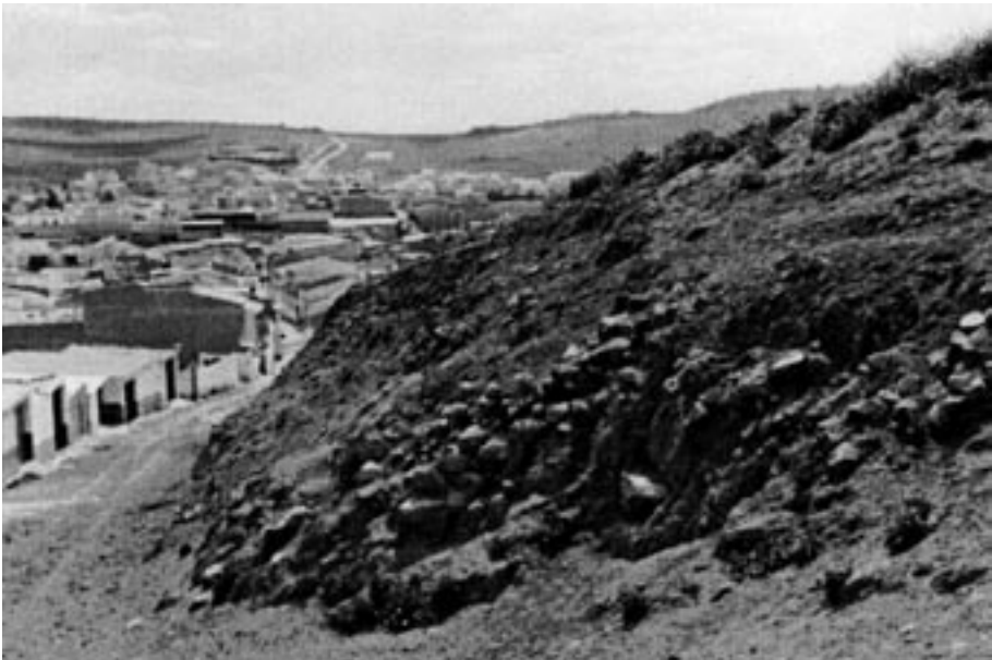
4. El Castillejo. Derrumbe de la ladera este.
