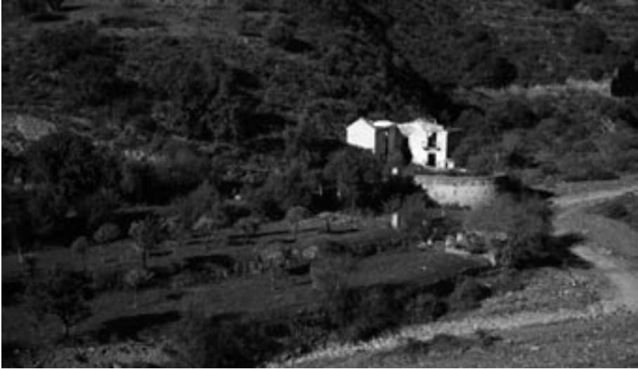
1. Huerta de Molina (P.R. Almendrales). El topónimo «huerta» ha sustituido a la denominación de «lagar» para nombrar a este tipo de construcciones. La importancia del regadío en esta finca, se pone de manifiesto por la presencia de los huertos que se observan en la imagen, situados en la ribera del Ayo. Jaboneros.
