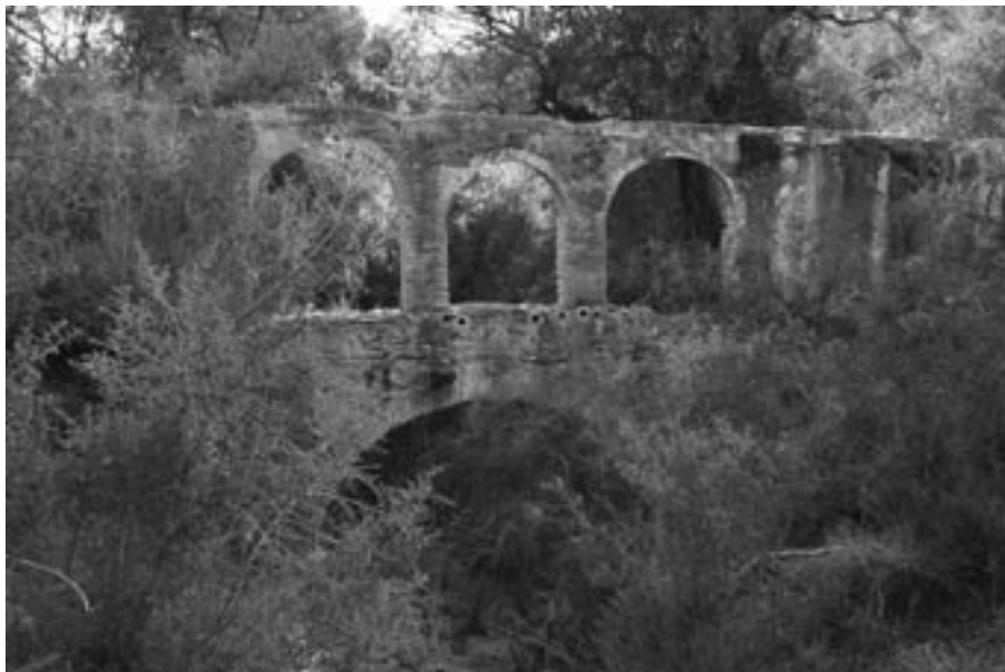
9. Gran atarjea de conducción de agua. Lagar de Almendrales (P.R. Almendrales).
