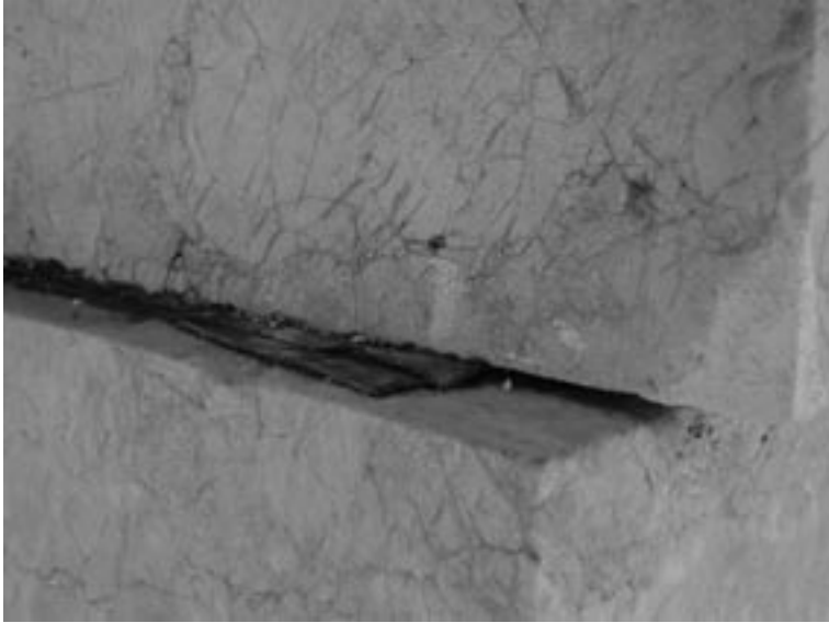
20. Detalle del asiento de la piedra con planchas de plomo en el monumento a Torrijos
