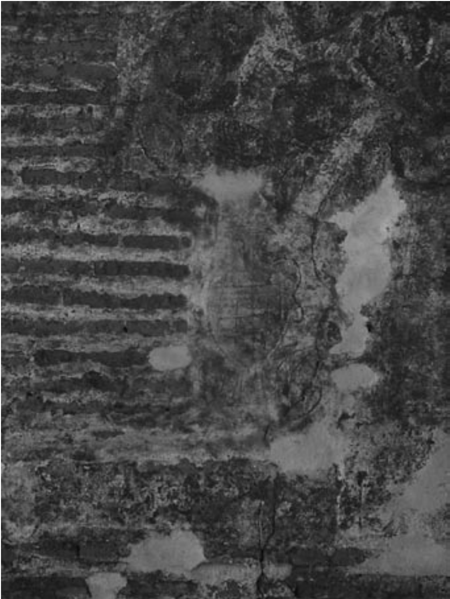
2. Detalle de la Torre Nueva de la Cala del Moral. Mijas
