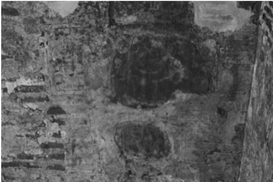
3. Detalle de la Torre Nueva de la Cala del Moral. Mijas
