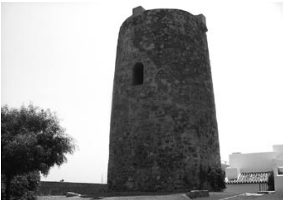
4. Torre vigía de planta circular
