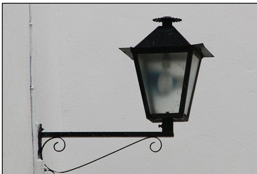
Imagen 4.7. Luminarias Calle de Atrás, Álora. Elaboración propia.
