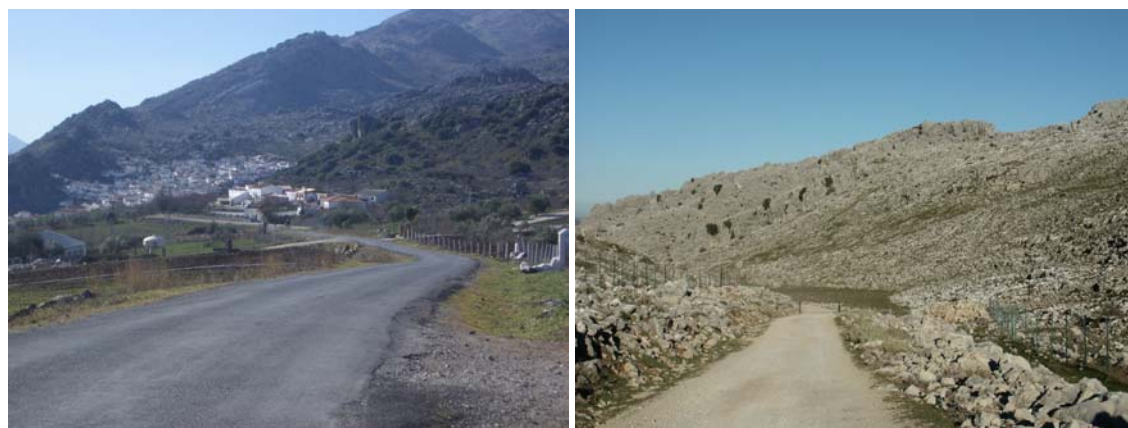
Foto 8.5. Detalle de la carretera entre cerro Tavizna y Montejaque (izquierda) y de la pista de acceso al Llano de Pozuelo desde Montejaque (derecha).
