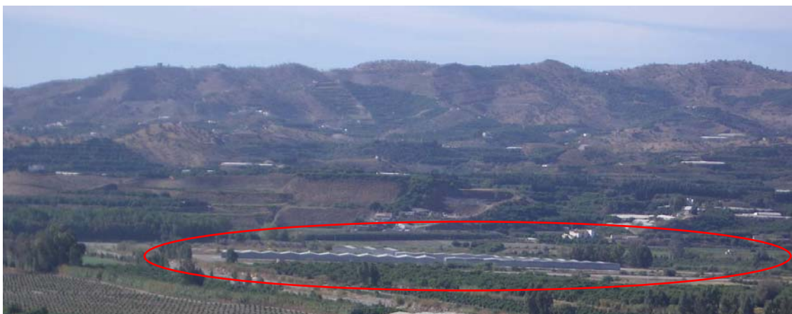
Foto 10.11. Pista de aterrizaje del aeródromo de Vélez-Málaga.
