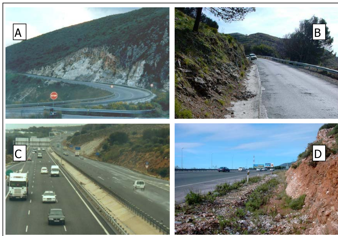
Foto 9.2. Vista de la carretera autonómica 344 en el tramo conocido como los “caracolillos” (A), carretera autonómica 387 entre Mijas y Alhaurín el Grande (B), autovía A7 a la altura del Palacio de Congresos de Torremolinos (C) y detalle de un lateral de la A7 sin canal de desagüe (D).
