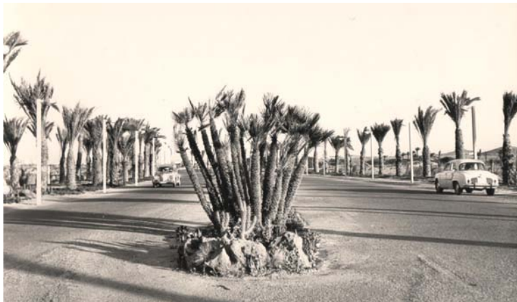
[Fig. 17] Imagen de la vía central que recorre toda la franja térrea de La Manga. Se trata de una vía de tráfico intenso controlado, con una anchura de 30 m con dos carriles de circulación en cada sentido y una mediana vegetal en el centro. Fuente: Archivo Histórico del Colegio ed Arquitectos de Cataluña.
