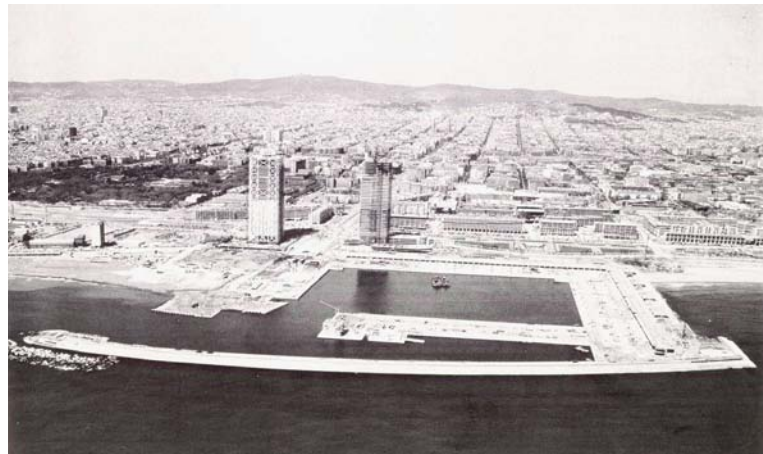
[Fig. 8] Imagen del proceso de construcción de la infraestructura náutica. La forma y tamaño de las dársenas finalmente construidas, mayor que en las propuestas iniciales, responden a requerimientos del programa olímpico. Fuente : MARTORELL, J.; BOHÍGAS, O.; MACKAY, D.; PUIGDOMENECH, A . La Villa Olímpica. Barcelona 92: arquitectura, parques, puerto deportivo. Barcelona: Gustavo Gili, 1991. Pág. 43.
