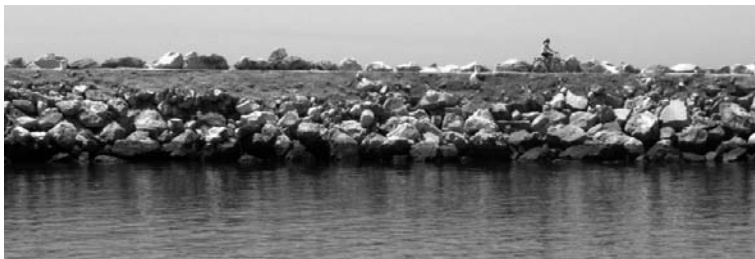
[Fig. 36] Imagen del dique de abrigo. Su perfil elevado no permite las vistas desde el interior del recinto hacia el mar abierto. Fuente: elaboración propia.
