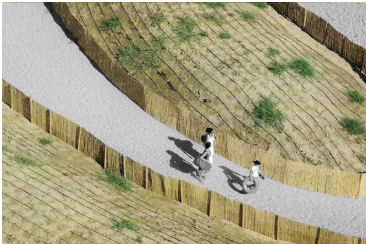
[Fig. 6] Imagen de dunas artificiales que permiten estabilizar la playa de Cala Ginesta a través del uso de materiales naturales. Fuente : tratamiento sobre foto original de Luca Colombari.
