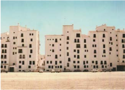
[Fig. 43] Imagen del alzado trasero de las edificaciones, en la actualidad fachada intergrada en entorno urbano. Fuente: VVAA. Guillermo García Pascual Arquitecto . Málaga: Colegio Oficial de Arquitectos de Málaga, 2008. Pág. 112
