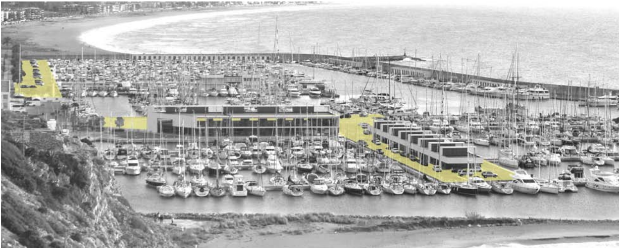
[Fig. 7] Imagen del paseo de borde junto a las embarcaciones. Obsérvese que los muelles están ocupados por grandes superficies de aparcamiento para vehículos. Tratamiento de imagen google.
