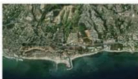
08 Marina de Cabopino, Málaga
