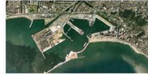
12 Puerto de Málaga, dársena interior y puerto de San Andrés
