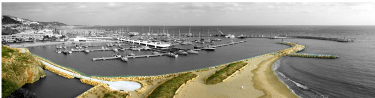
[Fig. 10] Imagen de la nueva dársena portuaria junto al macizo del Garraf y la playa de Cala Ginesta. Obsérvese el perfil bajo del contradique, el uso de materiales naturales –en este caso de piedra- en su formación y la estabilización de la playa a través de dunas de nueva creación con vegetación autóctona. Tratamiento de imagen google.
