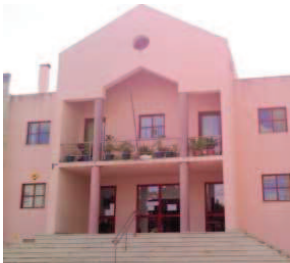
Figura 16: Entrada principal da EB1 Quinta da Granja.
