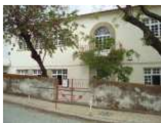
Fig.14 - Fachada frontal da escola
