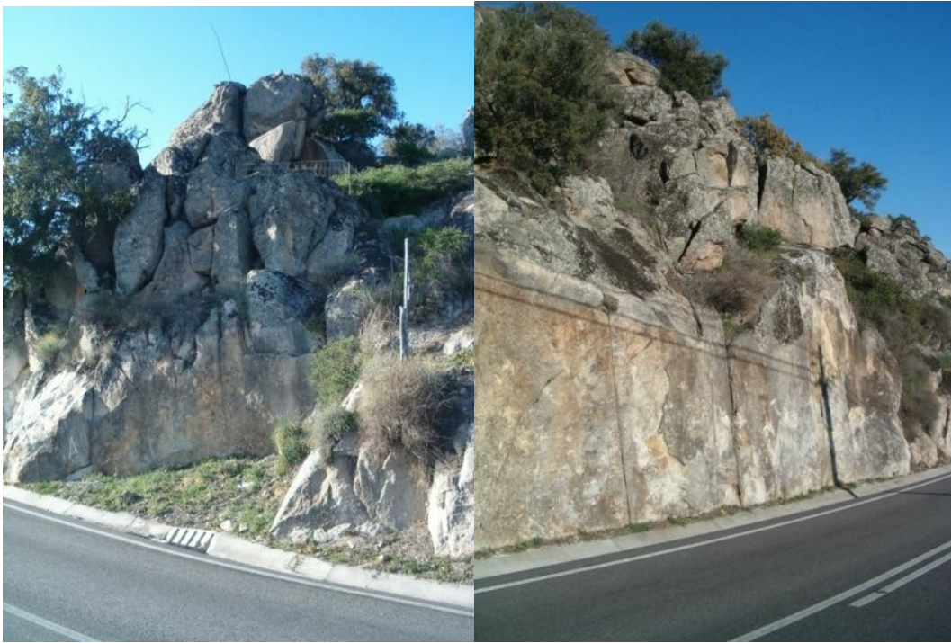
Figura 3 - Valeta existente no local, exclusivamente para efeitos de drenagem sem capacidade de retenção
