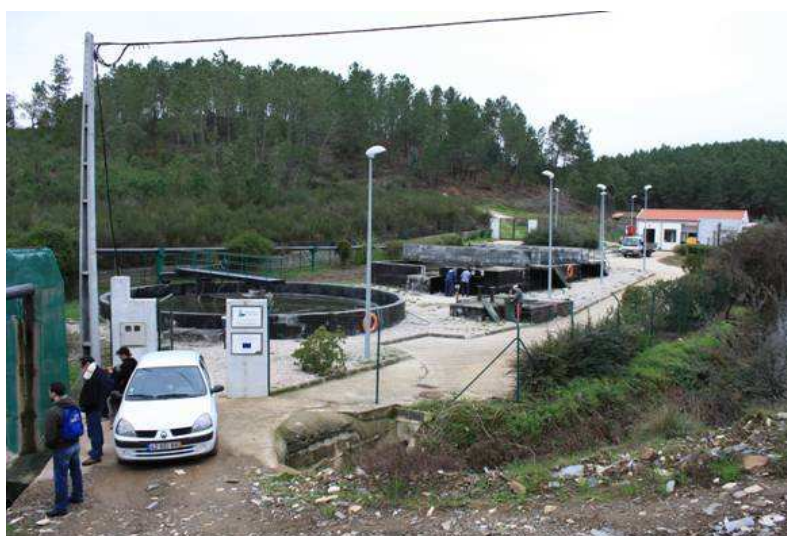
Figura 4.2 - Vista geral da ETAR de Proença-a-Nova
