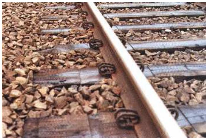
Figura 3.4 – Via balastrada com travessas de madeira, [Esveld, 1989].
