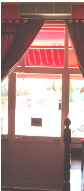
Fig.15 – Outro exemplo de uma situação em que é notória a interferência provocada pelo cortinado e respectivo varão no desenvolvimento de um jacto de ar plano descendente.
