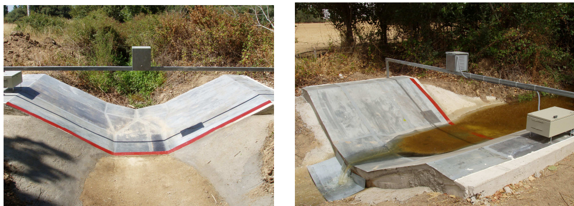
Figura 3.21 – Aspecto de la colocación de hormigón en la aproximación y salida del aforador.
