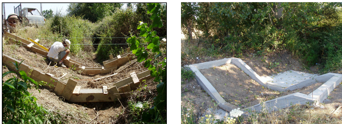
Figura 3.20 – Tramo del cauce principal donde se construyó el asentamiento de hormigón para el aforador.
