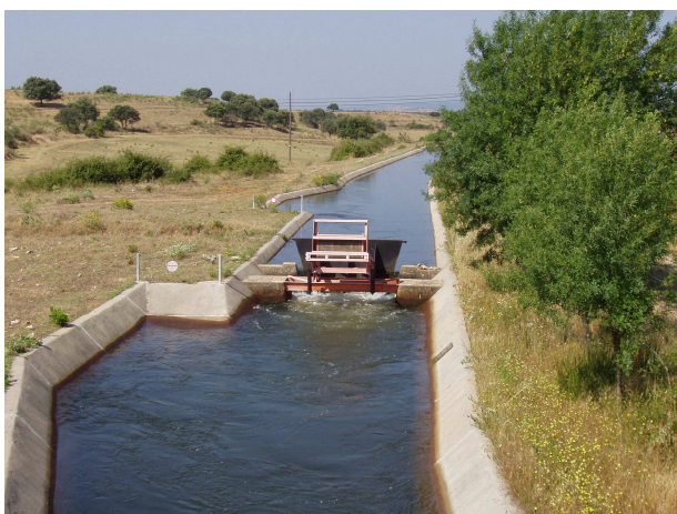
Figura 3.3 – Tramo de un canal conductor del agua, con una estructura hidráulica de control de los caudales.
