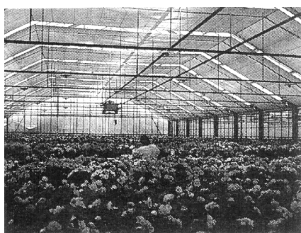
Figura 2.7 - Fotografia de estufa contendo ecrãs de sombreamento.
