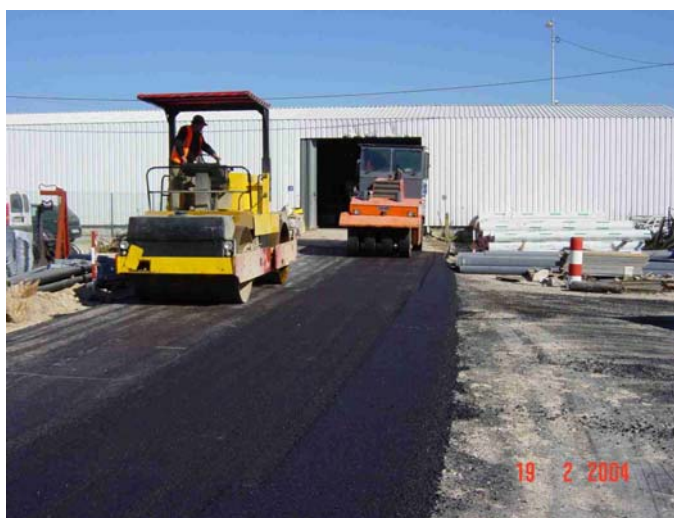
Figura 4.2 - Realização dos troços experimentais nos estaleiros da Rosas Construtores
