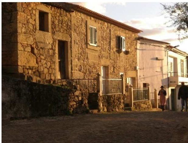
Figura 1: Casa construída em granito e barro
